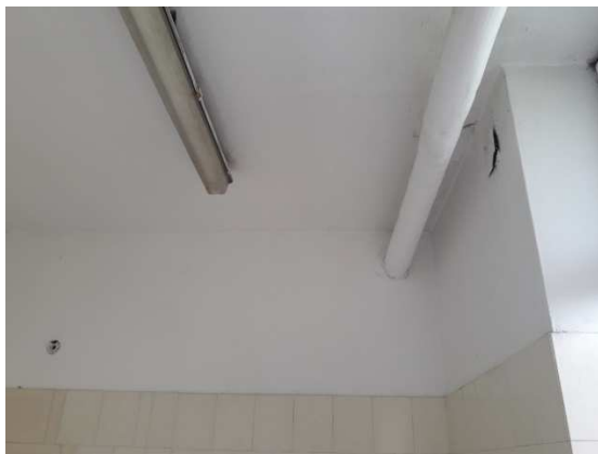
Figura 5: Particolare del soffitto, con lampada al neon e cassetta di derivazione
