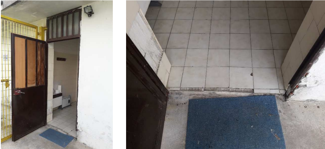
Figura 2: a) Ingresso dei servizi igienici; b) particolare della soglia
